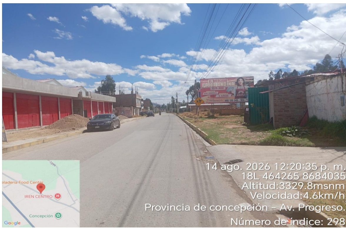
Imagen N° 05– Av. Progreso (Vista de futuro mercado de Oeste a Este )
