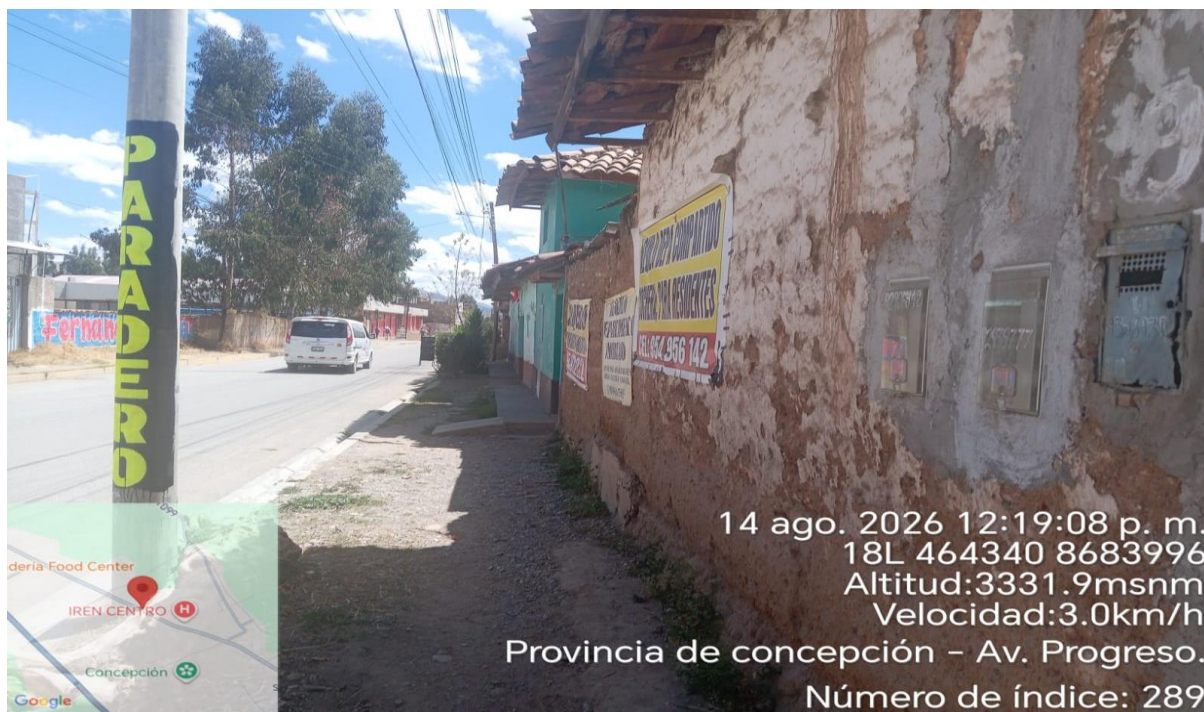
Imagen N° 10– Av. Progreso Progreso (vista de suministros de energía eléctrica)
