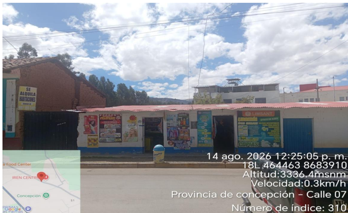
Imagen N° 04– Esquina de Av. Progreso y Proyeccion de Calle 07
